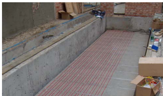
Рисунок 41 – Укладка теплого пола в доильной яме
