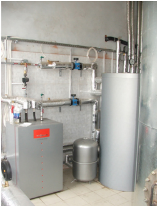
Рисунок 121 – Элементы системы обогрева и горячего водоснабжения бытовых помещений с применением теплового насоса мощностью 33,6 кВт
