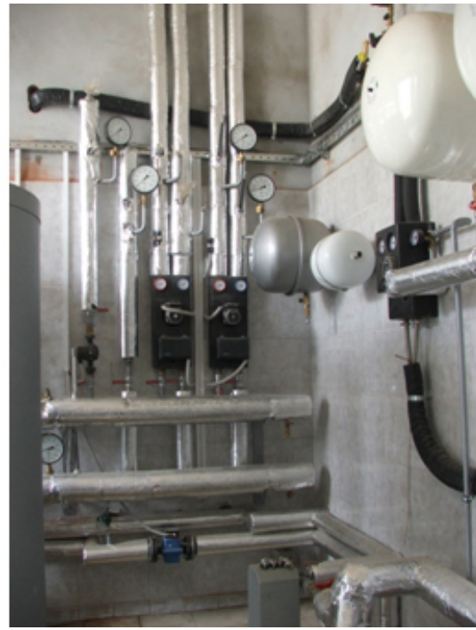
Рисунок 121 – Элементы системы обогрева и горячего водоснабжения бытовых помещений с применением теплового насоса мощностью 33,6 кВт
