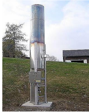
Рисунок 90 – Общий вид установки для осушки биогаза (а) и устройства автоматизированного факельного (б) для утилизации излишков биогаза в нештатной ситуации
