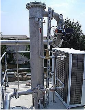
Рисунок 90 – Общий вид установки для осушки биогаза (а) и устройства автоматизированного факельного (б) для утилизации излишков биогаза в нештатной ситуации
