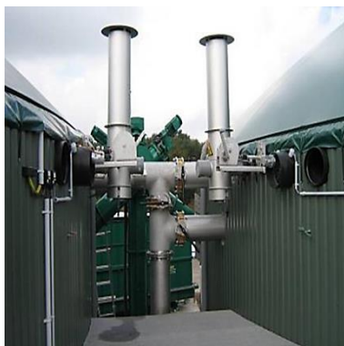
Рисунок 88 – Мобильная лаборатория с комплектом оборудования по технологическому, техническому обслуживанию и диагностике БГЭК (а) и вид в плане на предохранительные клапаны для ферментеров БГЭК (б)
