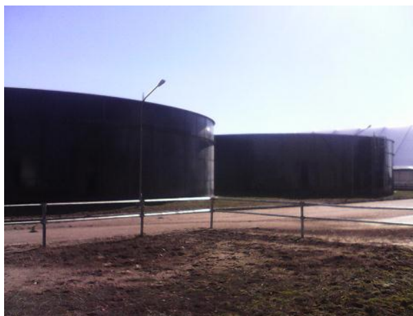
Рисунок 2. – Вертикально расположенный ферментатор биогазовых установок
