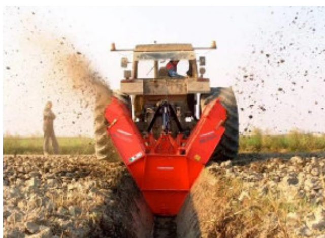
Рис. 7. – Двухфрезерный каналокопатель Cosmeco Big Storm во время строительства осушительного канала
