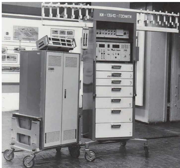
Рисунок 2 – Диагностическая измерительно-прогнозирующая система (ДИПС) КИ-13940-ГОСНИТИ на основе электронного измерительного комплекса К-736 Ленинградского института ВНИИЭП (разработка выполнена ВНИИЭП совместно с ГОСНИТИ, ЛСХИ, УкрГОСНИТИ и Киевским СКБ им. Ястребова)
