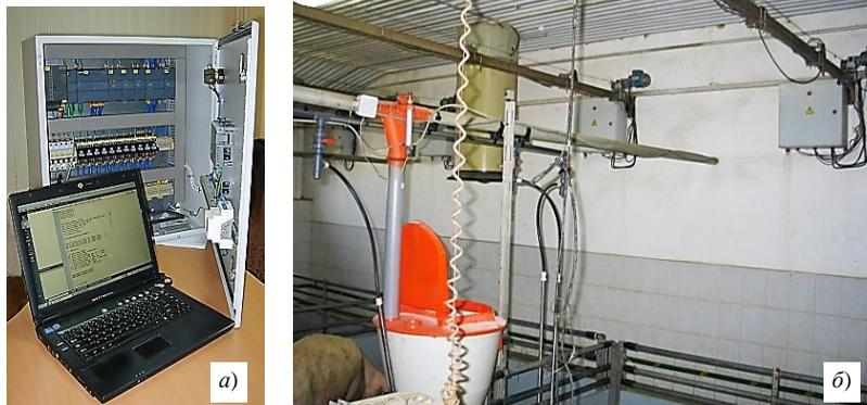
а) центральный шкаф управления; б) расположение блоков силового управления и системы мобильного подвеса ИК-излучателей в секции дорашивания поросят-отъемышей
