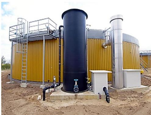
*Рисунок 89 – Общий вид десульфуризатора для очистки биогаза от сероводорода*
