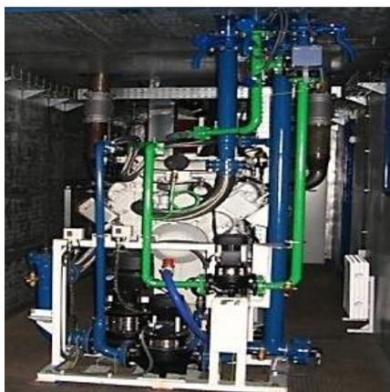
Рисунок 86 – Когенерационная газовая установка КГУ-250 (вид сбоку)
