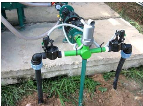
**Рисунок 60 – Выходной патрубок с регуляторами давления и воздушно-вакуумным клапаном**
