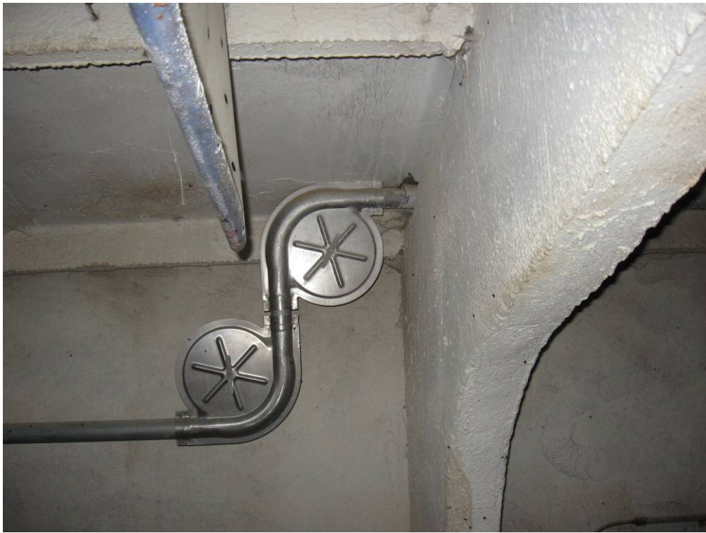
Рисунок 9 – Вид на поворотные устройства линии раздачи корма
