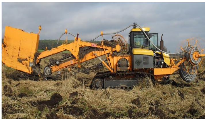
Рисунок 113 – Экскаватор-дреноукладчик с лазерным уклономером ЭТЦ-203 на приемочных испытаниях
